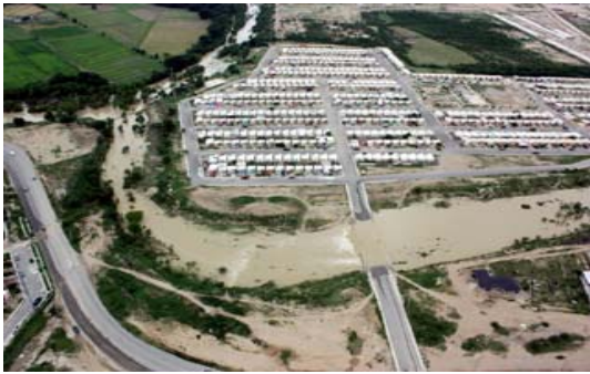
Vista de la afectación. Foto: Milenio.com
